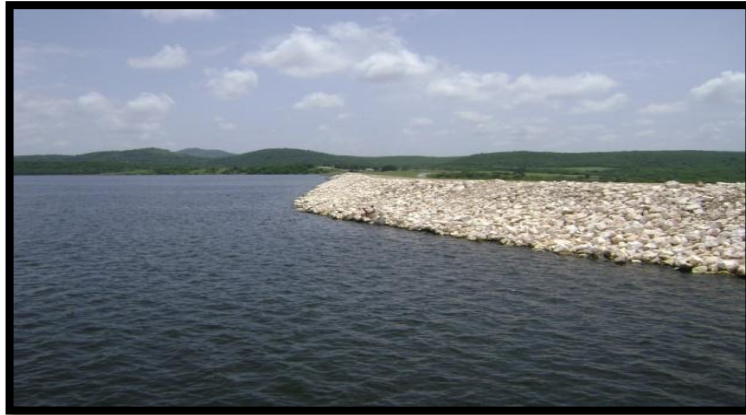
Figura 25. Talud aguas arriba.
