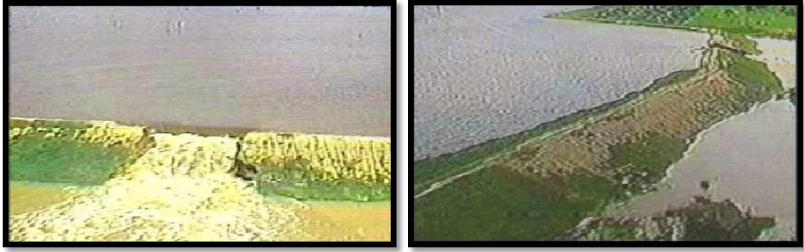
Figura14. Presa Las Cabrerías.
