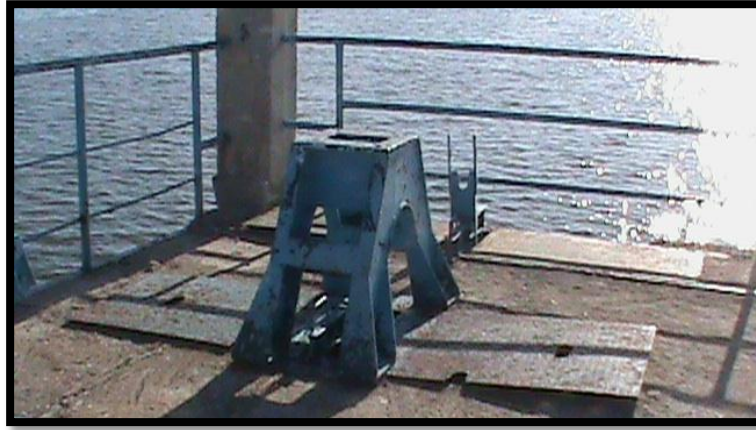
Figura 30. Elevadores de compuertas.
