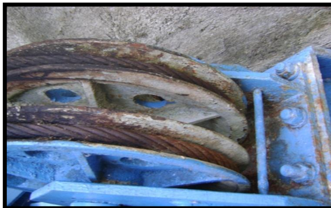
Figura 29. Polipastos del aliviadero.
