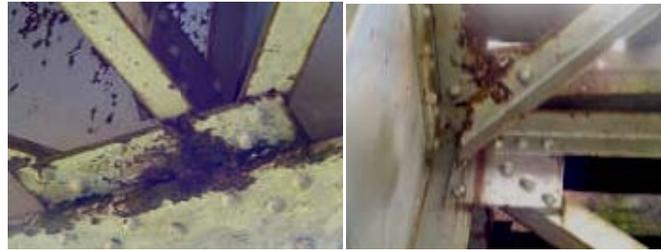
**Platabandas:** Disminuciones parciales del espesor de las platabandas superiores e inferiores por el efecto de la corrosión. Los remaches han perdido prácticamente las cabezas, sobre todo en la parte superior.
