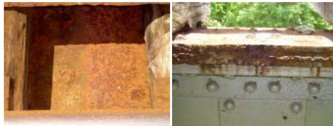
**Platos de asientos:** Corrosión en los platos de asiento de las vigas sobre los estribos, los tornillos están muy corroídos, algunos partidos y otros con disminución del diámetro. Tiene además muy oxidados los angulares extremos de las vigas que conforman los rigidizadores en la misma zona.
