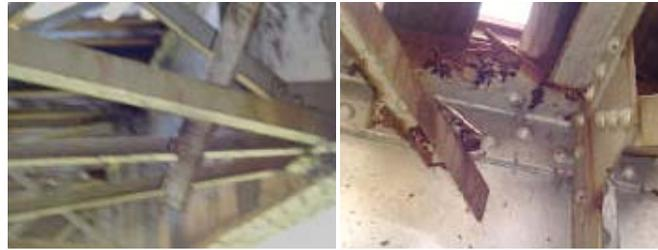
**Planchuelas de enlaces:** Tiene muy corroídas las planchuelas de enlace de los arriostramientos horizontales superiores a las vigas principales.
