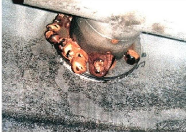
Figura 12. Corrosión Galvánica.
