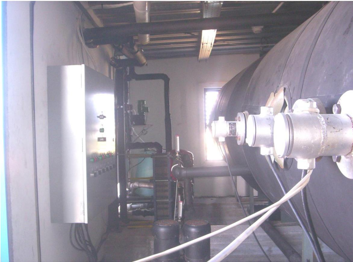
**Figura 4: Sistema para la producción de agua caliente en los bungalow.**
