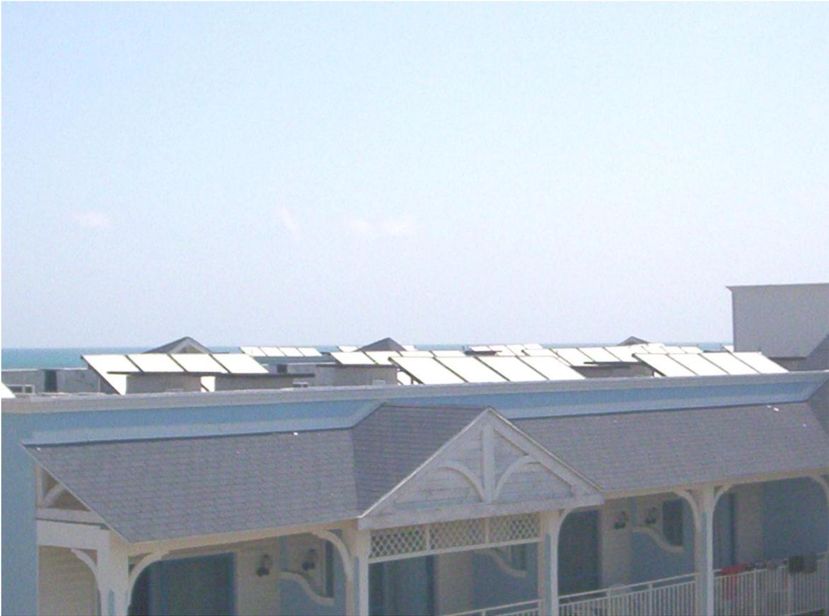
**Figura 3: Ubicación de los colectores solares, para la producción de agua caliente en las habitaciones.**
