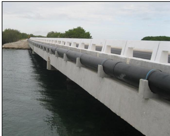
**Figura 11. Tubería de PEAD utilizada en la conductora**
