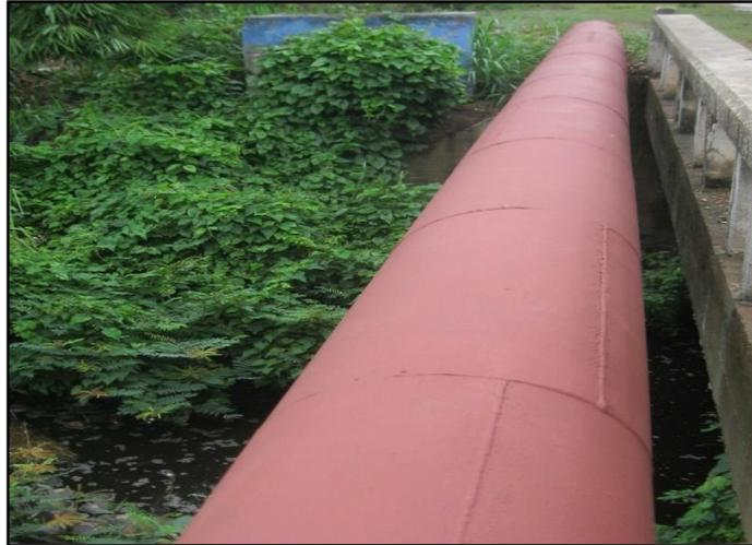
**Figura 12. Tubería de acero utilizada en la conductora**
