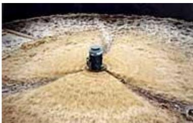
**Aireador de escobilla:** El agua es lanzada al aire al girar, paralelamente a la superficie, una escobilla semisumergida en el agua.
