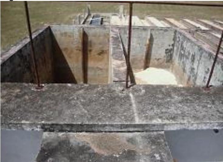
Figura 4: Filtros lentos en mal estado.
