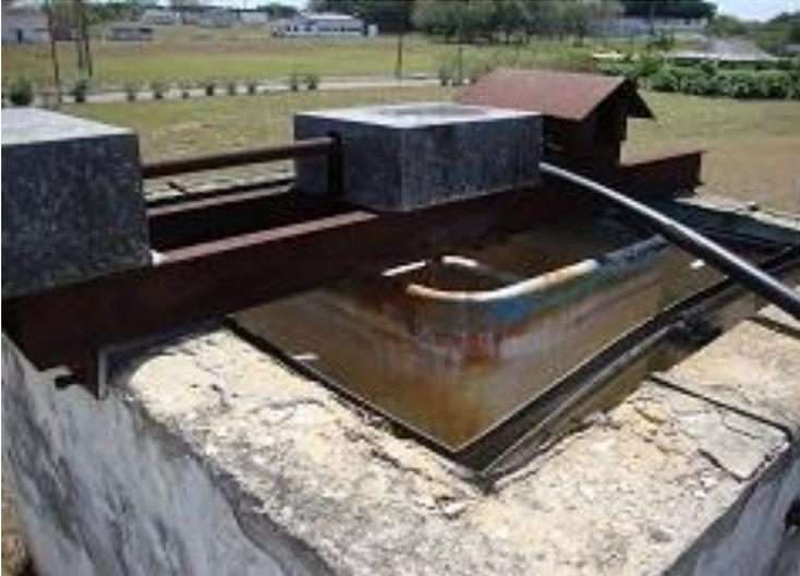
Figura 3: Floculador en mal estado técnico.
