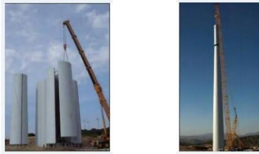
**Figura 1.11.** Torre de hormigón
