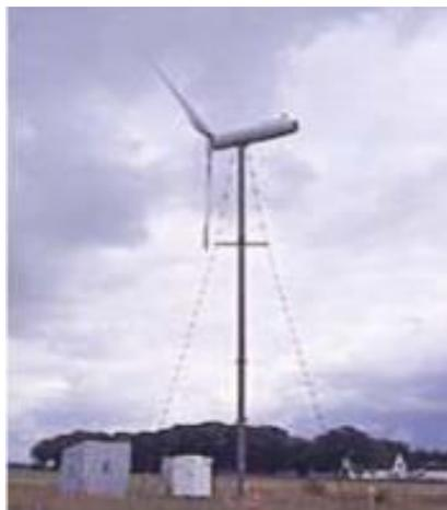
**Figura 1.12** Torre tubular de acero atirantada.
