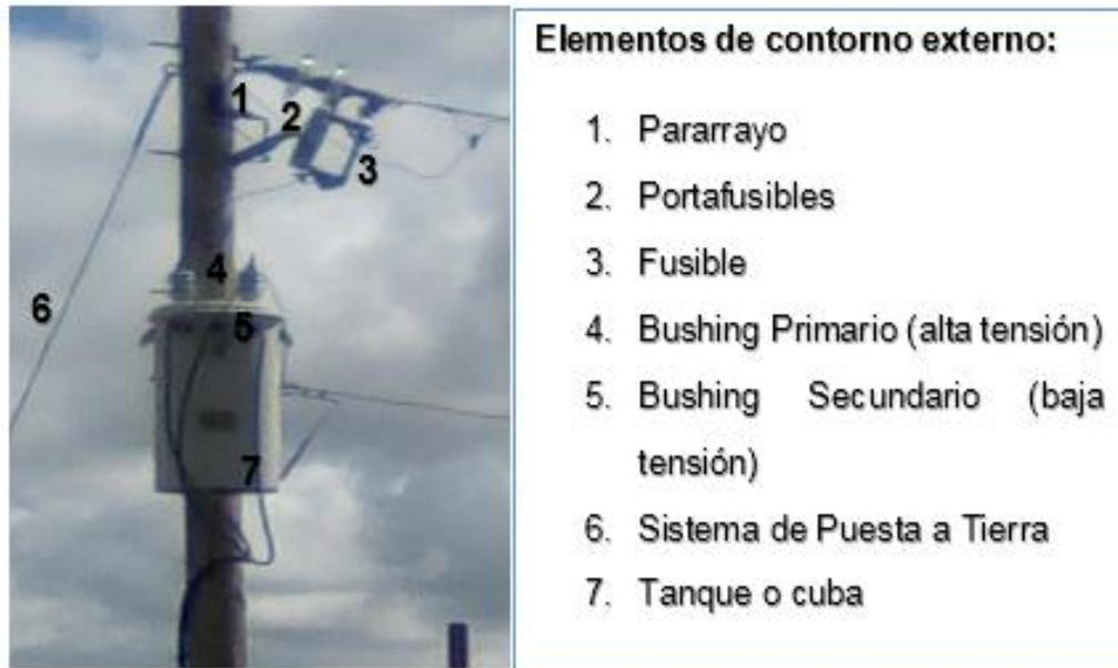
Figura 2.7. Características externas de los transformadores de distribución.
