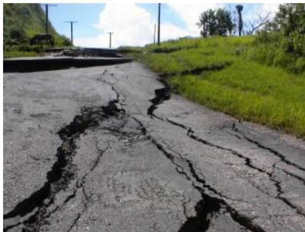
Fig. 5: Deslizamiento de tierra por saturación del suelo en una carretera de montaña en Cienfuegos, Cuba, 2005.
