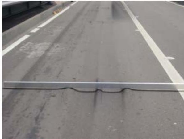
Fig. 8: Ahuellamiento en carpeta asfáltica.
