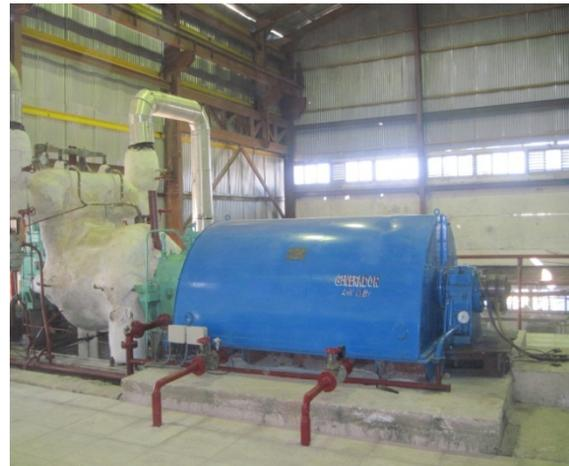
**Figura 2.2 Turbogenerador 2MW**
