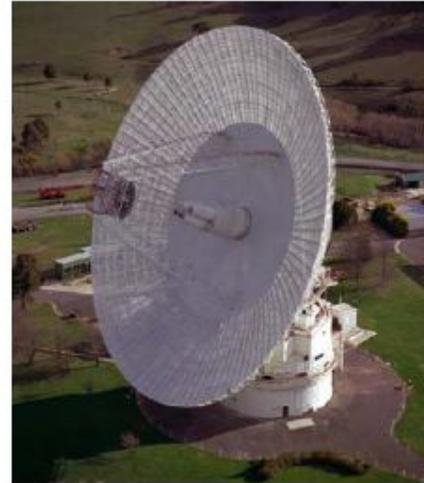
Fig. 1.5: Antena parabólica Gregoriana (Autor desconocido, 2014. (1)).
