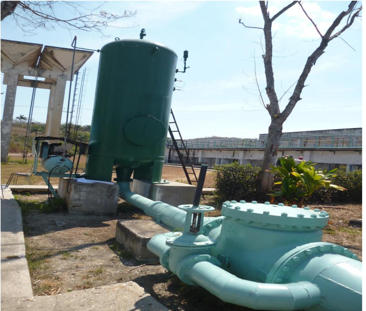
Figura 14. Tanque hidroneumático que se encuentra en la estación de bombeo.
