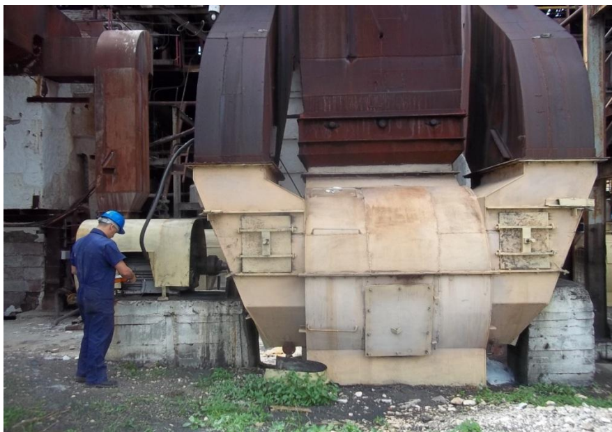
Figura 2.1: Ventilador de tiro inducido de doble succión (VTI).
