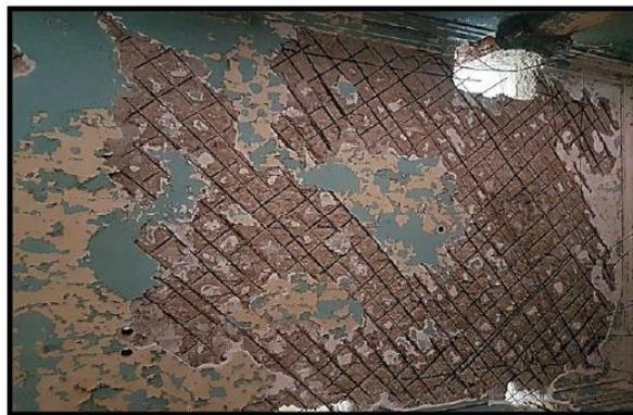
Fig. III.13 Imagen de losa de entrapiso con exposición de acero de refuerzo.
