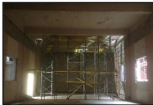
**Fig. III.18** Ubicación de los andamios para la colocación de los sensores.
