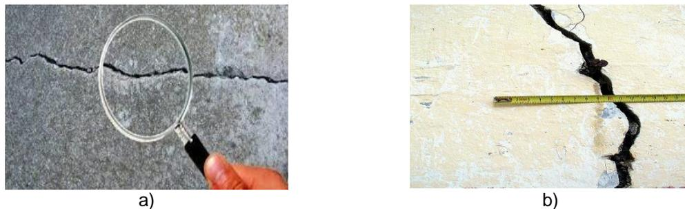
**Fig. II.3** a) Fisuras b) Grietas, presentes en las edificaciones. (Betancourt, 2017)
