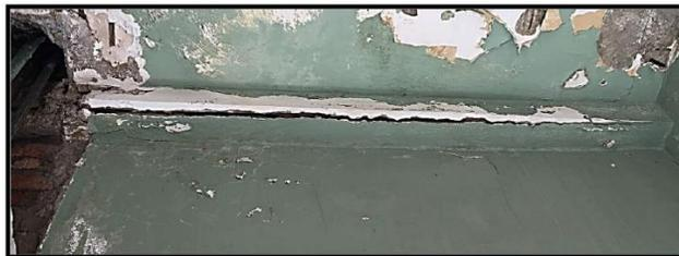
Fig. III.7 Grieta causada por la corrosión de un perfil metálico.
