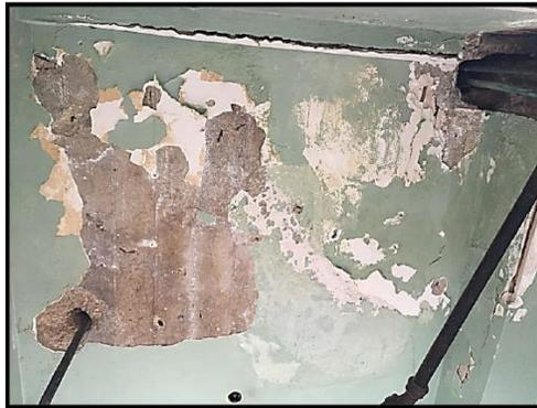
Fig. III.6 Humedades accidentales y por filtración en losa de entrapiso en el quinto nivel.
