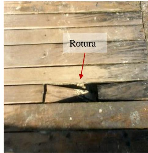
Figura 8. Desgaste, madera agrietada y rotura de partes del entablado.
