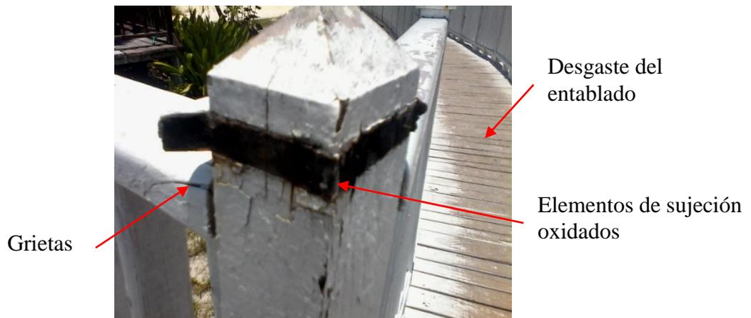
Figura 9. Desgaste generalizado, elementos oxidados en sus barandales y grietas.
