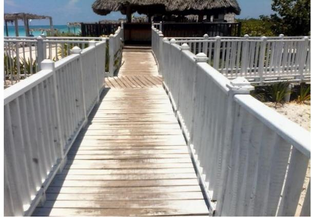
Figura 7. Desgaste en el entablado producto de la acción del paso de las personas.
