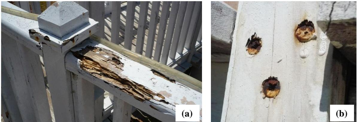
Figura 6. Fotos de la pasarela, (a) degradación por termitas, (b) detalle de la corrosión de los tornillos de fijación.
