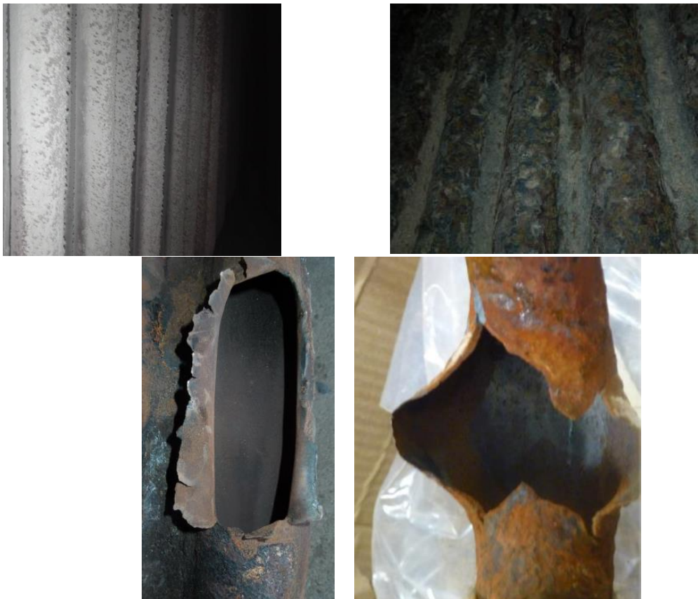
Figura 10 Ejemplos de presencia de incrustaciones y corrosión en zonas de alta temperatura y su impacto (roturas)
