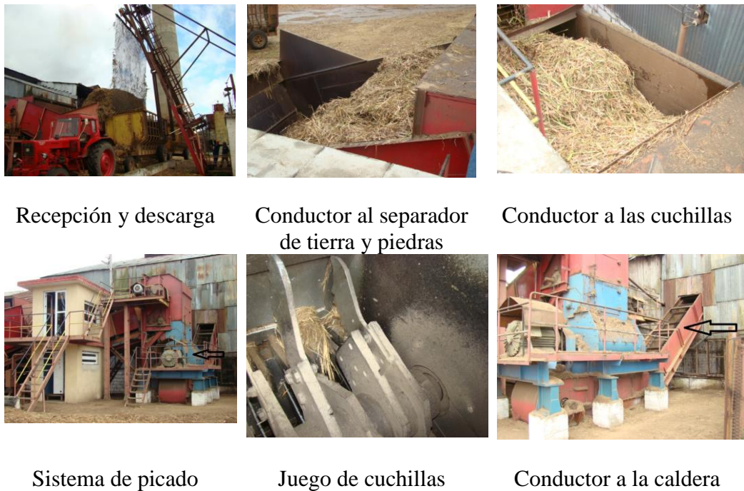
Figura 4 Instalación cubana de procesamiento de RAC Refinería Chiquitico Fabregat. Villa Clara.
