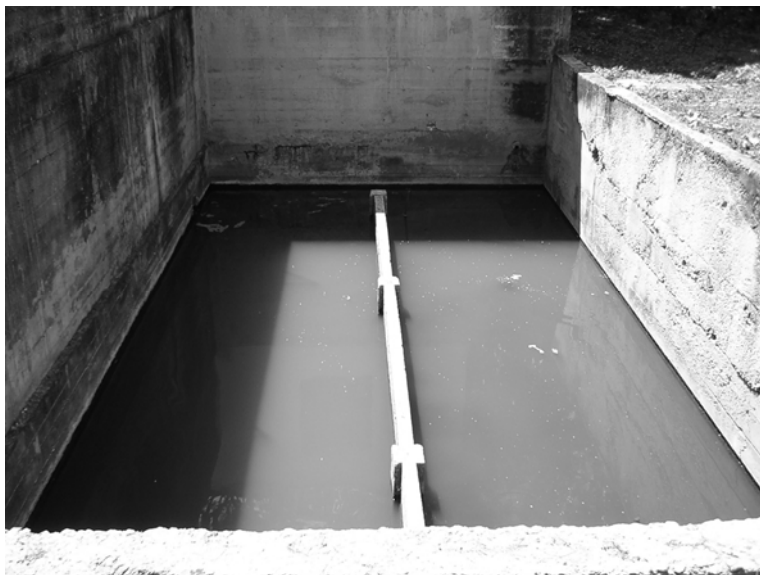
Figura 2.3 Sedimentador secundario
