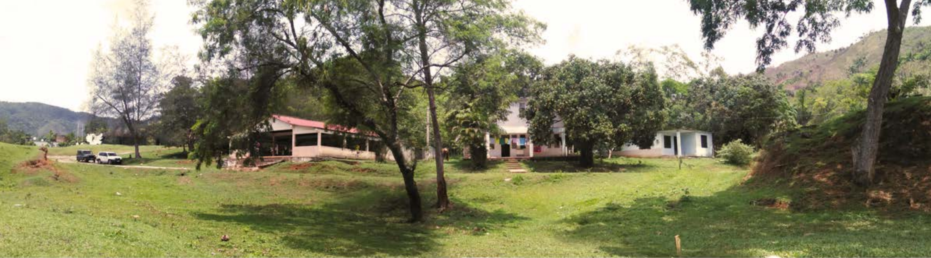
Fig_1: Panorámica de Gavilanes. Fuente: Elaborado por el autor
