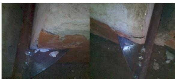
**Figura 3.1 Desprendimiento de la capa de hormigón detrás de las cartulinas.**
