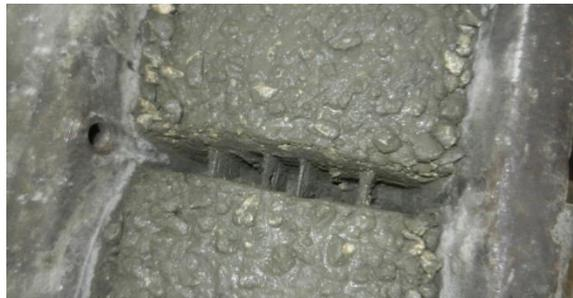
**Figura 2.25 Hormigón en los moldes luego de retirados los diafragmas.**
