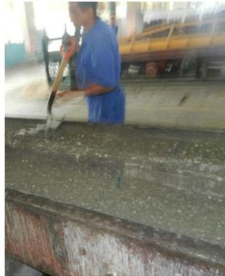
**Figura 2.24 Obrero realizando la nivelación con pala plana.** Fuente: Elaboración propia.
