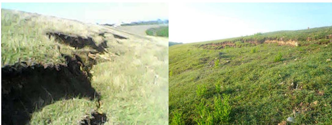
**Figura 3.1. Fallas locales del talud en el dique auxiliar de la presa Alacranes (a la izquierda en 2014 y a la derecha en 2018).**
