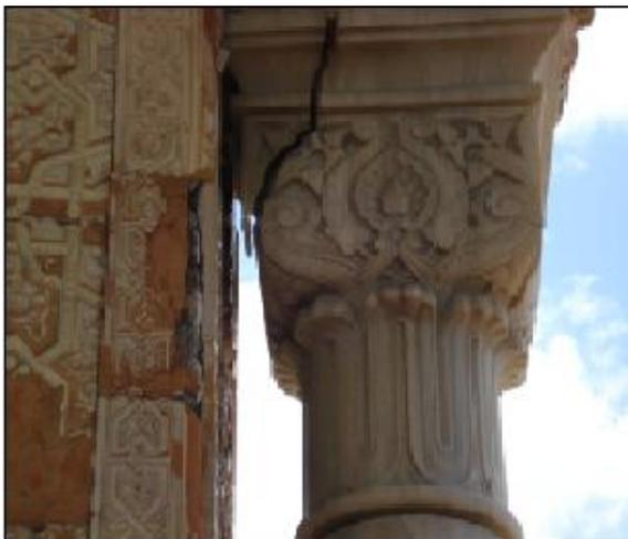
En el plano de arranque de los arcos y su apoyo sobre las columnas se aprecian grietas de hasta 5mm y en algunos casos existen fracturas en la parte superior de las columnas de mármol que comprometen su capacidad resistente.
