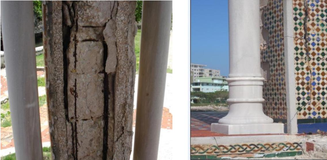
En las columnas estructurales se pudo observar la presencia del revestimiento de losas cerámicas y se puede apreciar:
