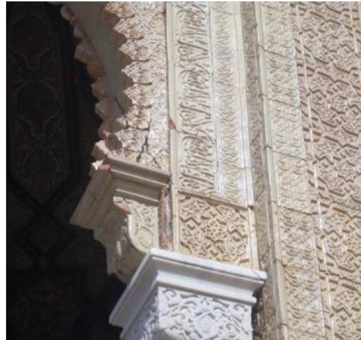
En este elemento se observan fisuras de hasta 3mm y grietas de 6mm en sentido longitudinal en la cara inferior de algunos arcos que no comprometen la función estructural del objeto de obra. Las mismas deben de ser intervenidas de acuerdo a las recomendaciones realizadas posteriormente.
