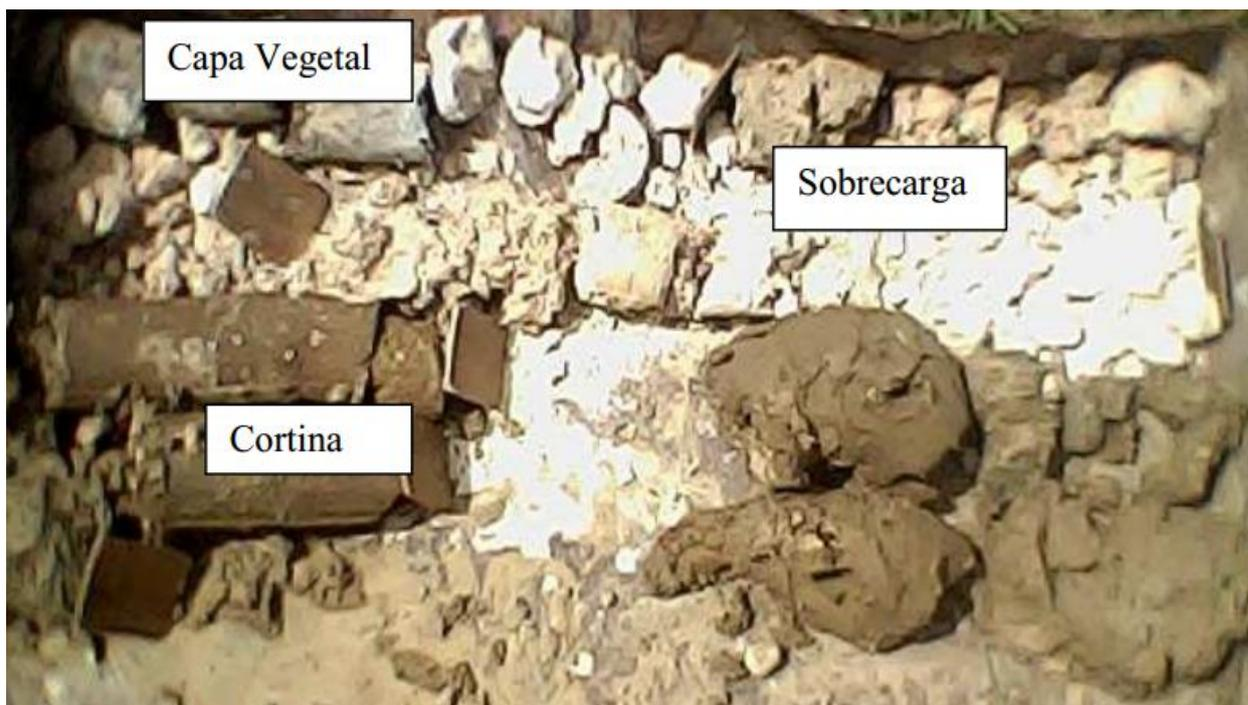
Figura 15. Foto de una cala tipo de la berma con sobrecarga y debajo el material de la cortina, no se observa el material filtrante (arena y gravas) de transición (Pérez., 2000).
