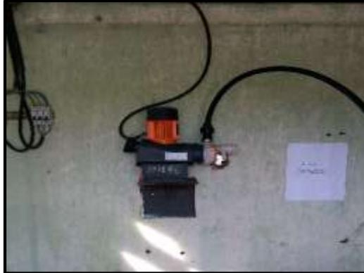
**Figura 2.11. Bomba dosificadora de cloro existente.**
