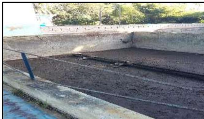
**Figura 2.7. Interior de los filtros, donde se observa el sistema de retrolavado.**
