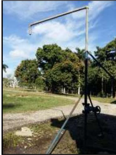
**Figura 2.10. Toma de agua de los camiones cisterna.**
