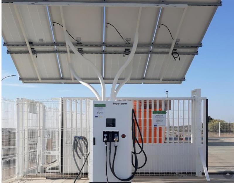
**Figura 2.1: Estructura en forma de pérgola.**
