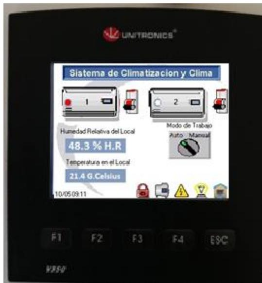
*Figura 64 Pantalla del Clima con el modo Automático activado.*
