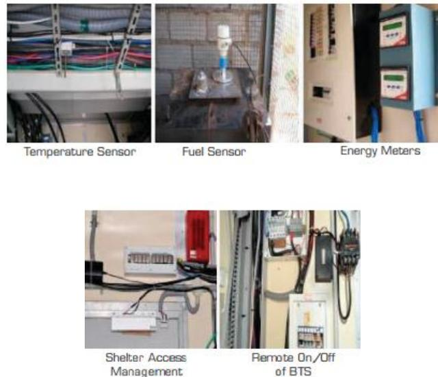
Figura 45 Sensores transductores de temperatura y combustible, medidor de energía, manejo de acceso al local y operadores remotos de ON/OFF utilizados en la implementación de TECH MAHINDRA.
