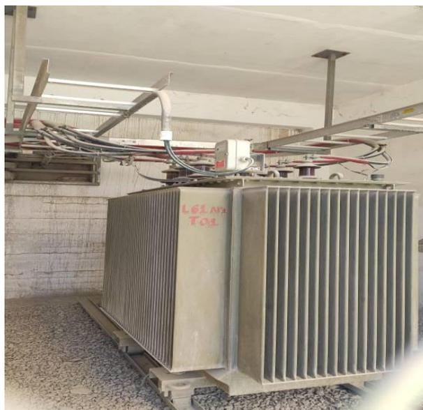
Fig B: Transformador de 6 kv/460 V
