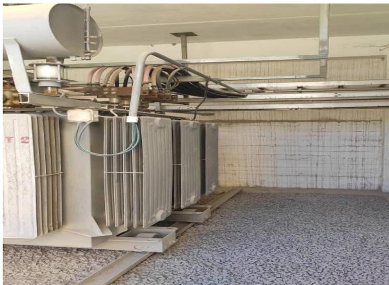
Fig A: Transformador de 6 kv/460 V
