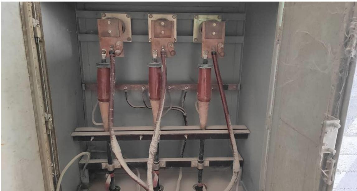
Fig D: Conexión conductores 6 KV
