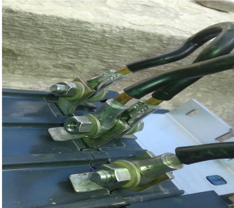
Fig C: Conexión de conductores 480 V
