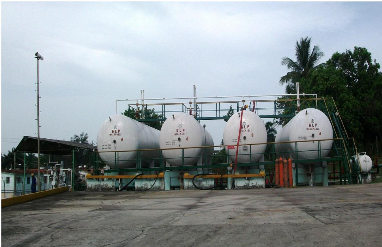
*Figura 3.3. Foto del área de riesgo **ARI**, zona de descarga y almacenamiento de GLP*
