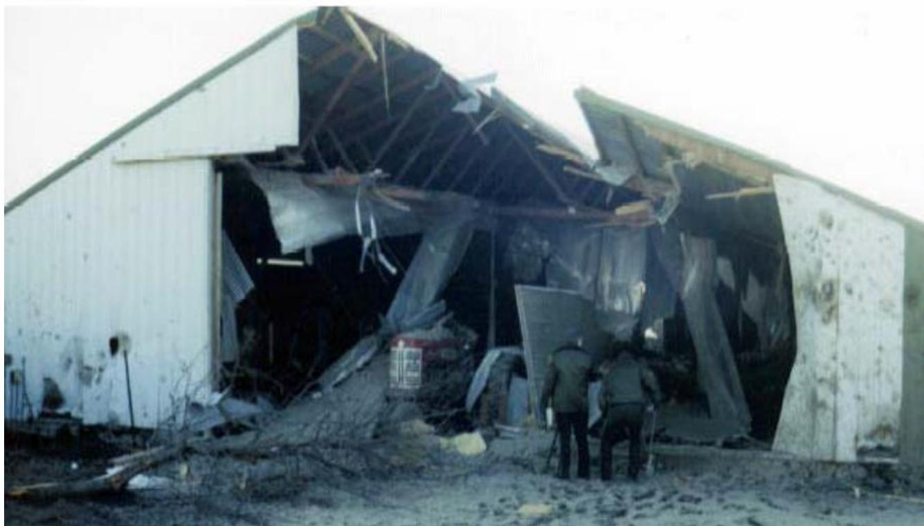
*Figura III.6. Daños producidos en una nave, por el impacto del fragmento de la Figura III.7 en Albert City (Iowa) en 1998, (Díaz, 2006)*
