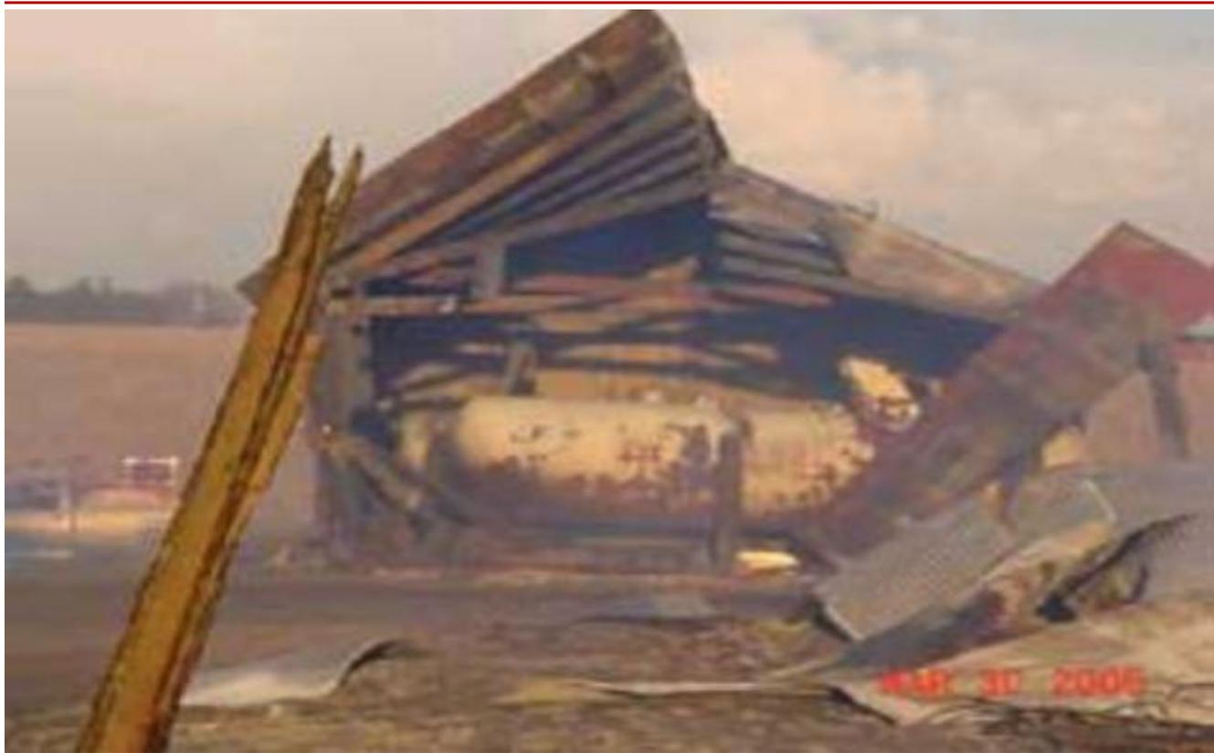
*Figura III.8. Fragmento de un tanque de GLP que destruye un almacén en una explosión en Monmouth (Illinois) en 2005, (Díaz, 2006)*
