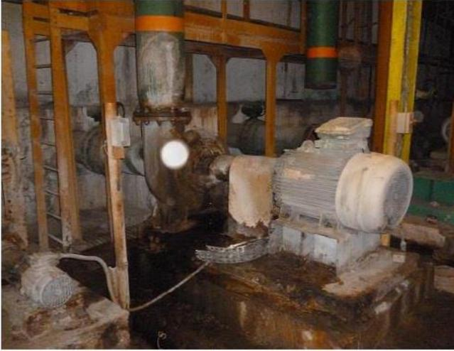
Foto 8. Bombas que serán sustituidas en la estación de bombeo de la Planta Potabilizadora.
