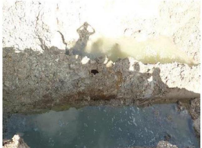
Foto 2. Agujero en la tubería conductora Cercano a la cerca de la potabilizadora
