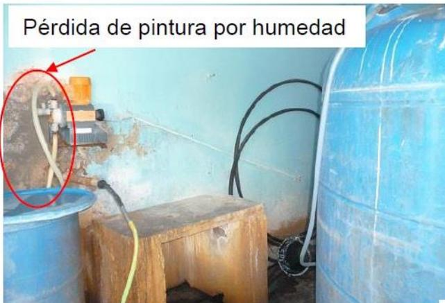
Foto 5. Tanque de cloro y bomba que le suministra cloro al agua de consumo.
