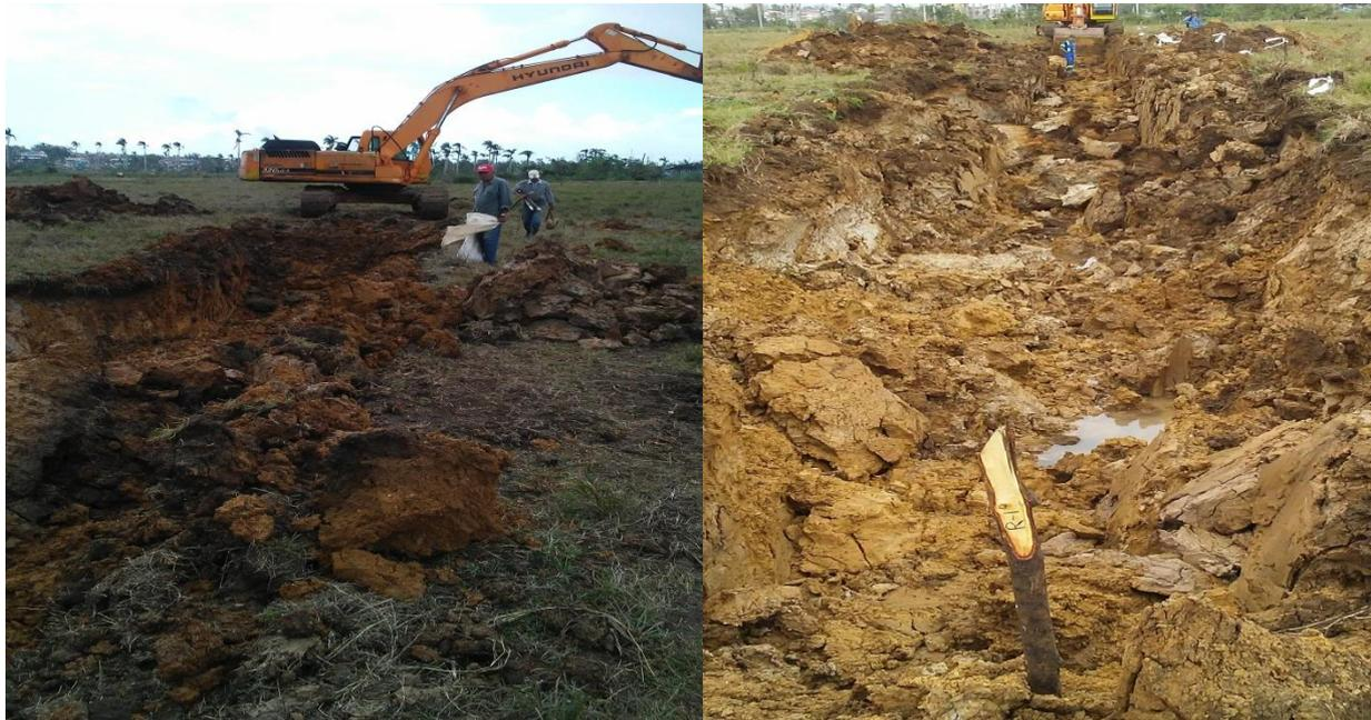
**Figura 2.7:** a) Retroexcavadora en operaciones, b) Destape de la trinchera 1 (T1).
