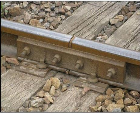
Fig. 1.10 Ilustración de junta aislante
