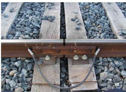
Fig. 1.9 Conector de continuidad de carril
