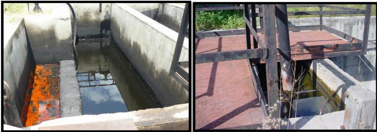
**Figura 2.4** Separador API sucio y con deterioro constructivo.
