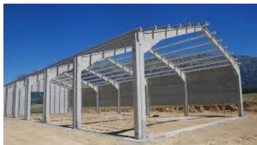
Figura 1.2. Estructura metálica porticada
