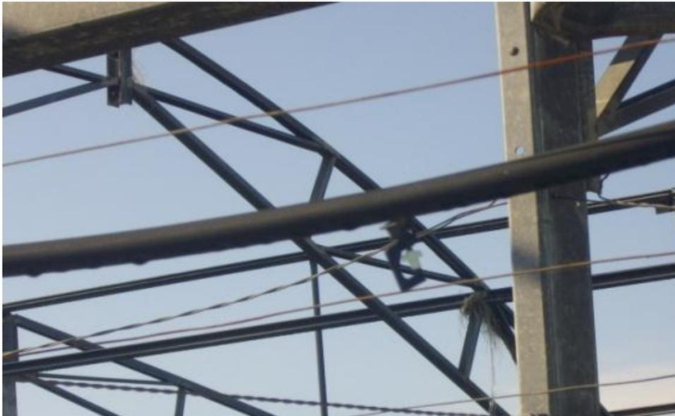
Figura 2.2 Sistema de riego por nebulizadorme
