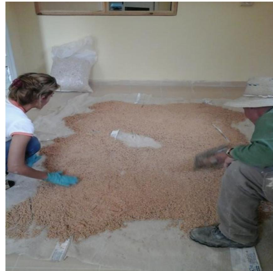
Figura 5: "Secado del árido fino".
