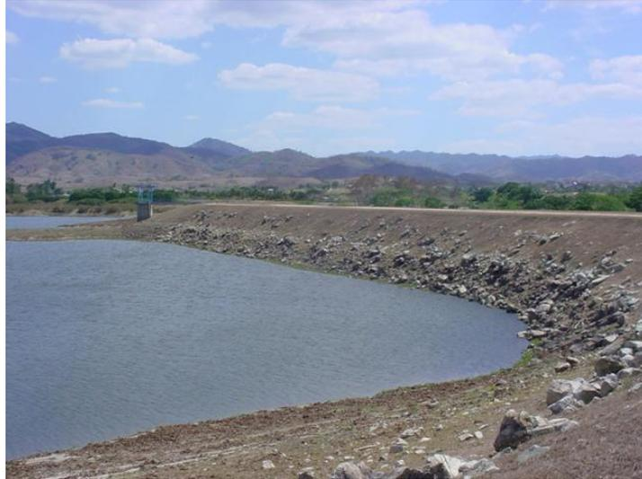
**Figura 36.** Talud aguas arriba con escasa protección contra el oleaje.
