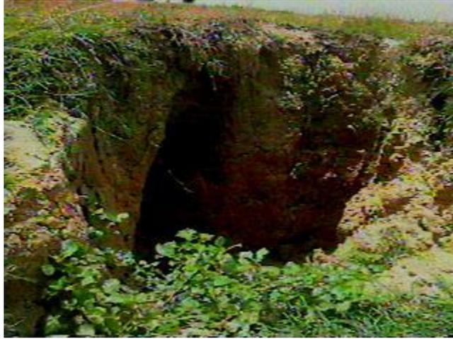
**Figura 4.** Caverna provocada por el sifonamiento de los suelos dispersivos en la Presa Las Cabrerías.
