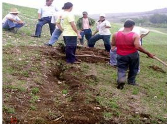
**Figura 9** Agrietamiento longitudinal, Presa Alacranes.
