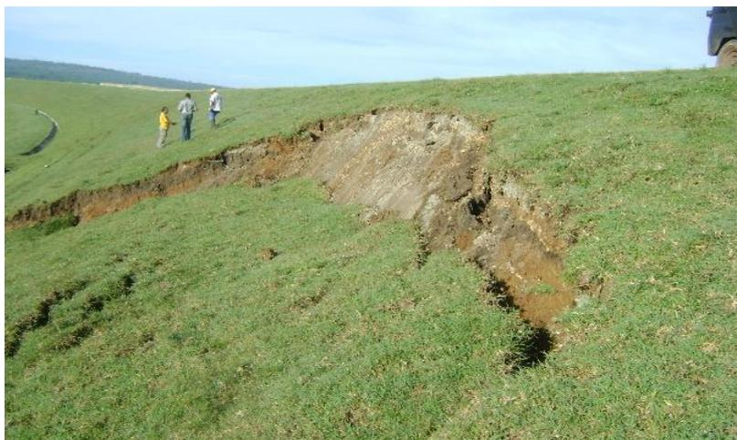
**Figura 6.** Deslizamiento del talud aguas abajo, Presa Amistad Cubano-Búlgara.
