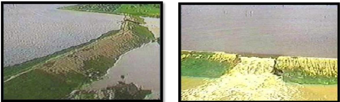
**Figura 3.** Ruptura de la cortina de la Presa Las Cabrerias.
