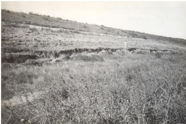
**Figura 8.** Deslizamiento del talud seco, Presa Herradura (1988).
