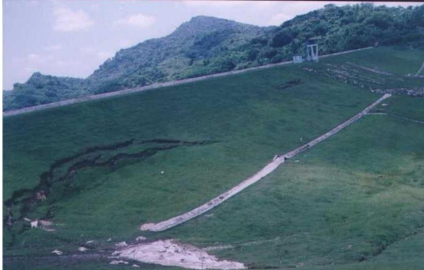
**Figura 7.** Deslizamiento del talud aguas abajo de la Presa Lebrije (Foto tomada el 14 de junio de 2002).
