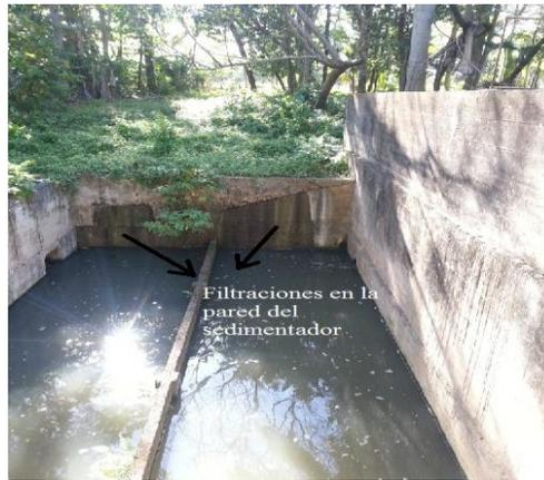
Figura 2.4 (Sedimentador secundario)
