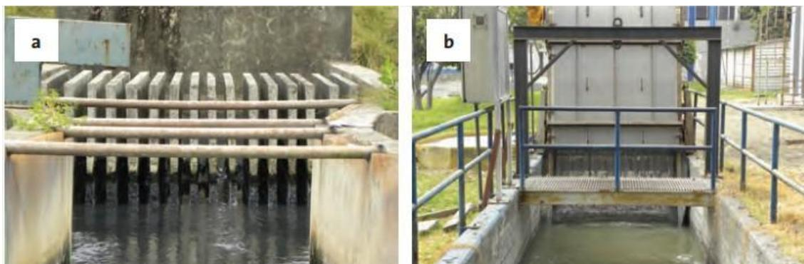
Figura 1.1. Rejillas y sistemas de desarenado.
