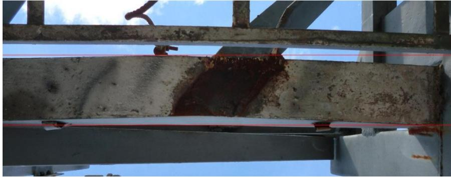
Figura 2.4. Vista inferior del elemento deformado
