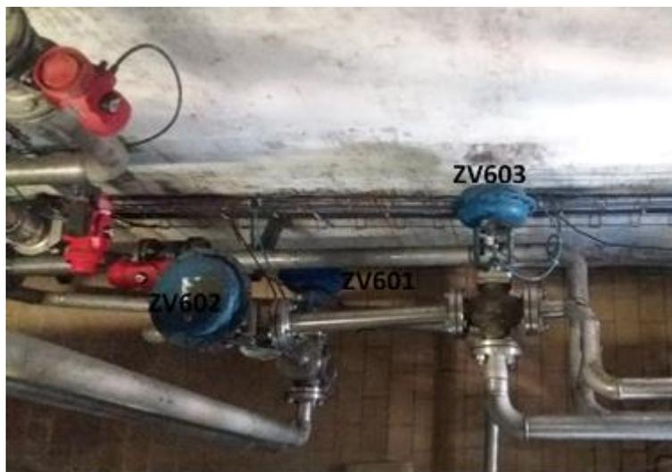
Figura 2.16. Válvulas de salida del condensado vegetal
