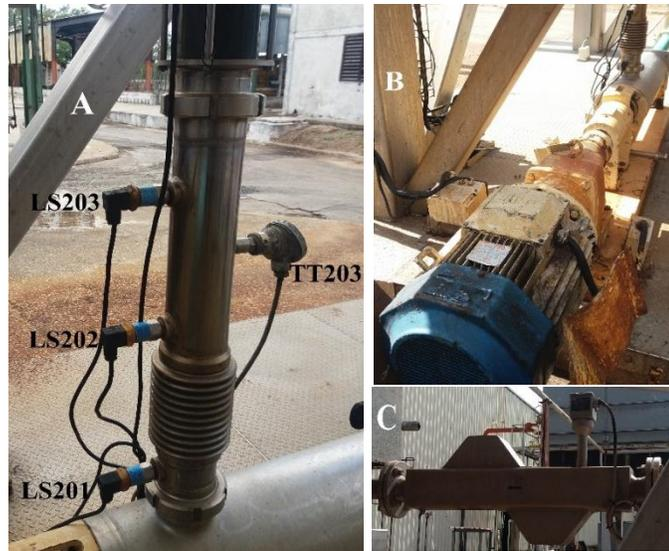
Figura 2.7. a) Salida del enfriador, b) Bomba M204, c) Flujómetro.
