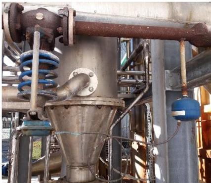
Figura 2.9. Válvula reductora de vapor
