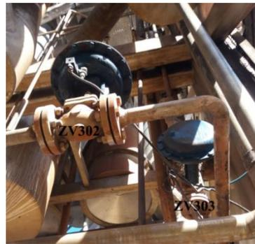
Figura 2.12. Válvulas de los eyectores de vapor.
