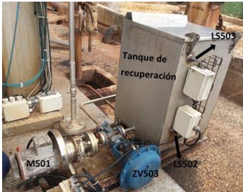
Figura 2.15. Línea de recuperación del agua de sellaje.
