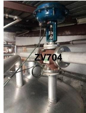
Figura 2.18 Válvula de tres vías.
