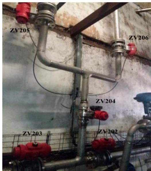
Figura 2.8. Válvulas de salida del concentrado.
