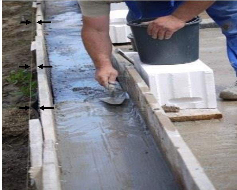
Figura: 3.7: Encofrado horizontal de vigas de cimentación en una obra. Medidas de rectitud.
