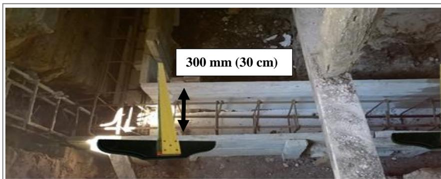
Figura 3.2: Forma de establecer las medidas de dimensiones transversales en el encofrado.
