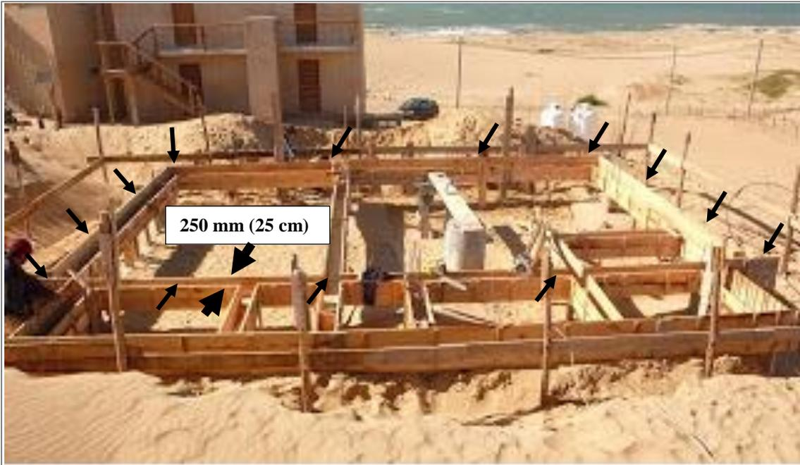
Figura: 3.1: Encofrado horizontal de vigas de cimentación en una obra. Situación de las medidas a tomar.
