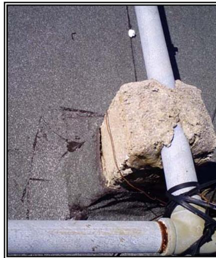
En algunos lugares incorrecta adherencia de los solapes de la manta en el plano horizontal, Este deterioro permite la entrada de humedad hacia el interior (Figuras 46 y 47).
