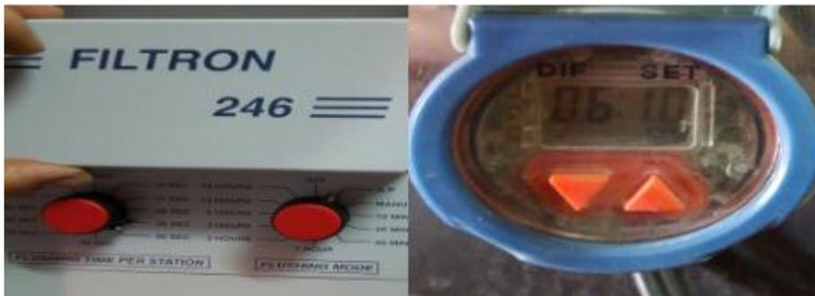
Figura 2.3 Programador de lavado y presostato
