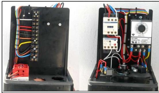
Figura 2-2 Caja de control de la penúltima torre, con sistema antipatinaje.
