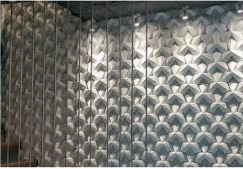
Fig. 10 Muros de celosías de piezas de morteros.
