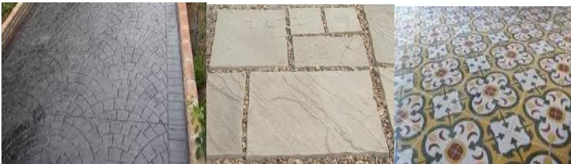
Fig. 65. Pisos de piedra artificial hormigón, terrazo y losas hidráulicas.
