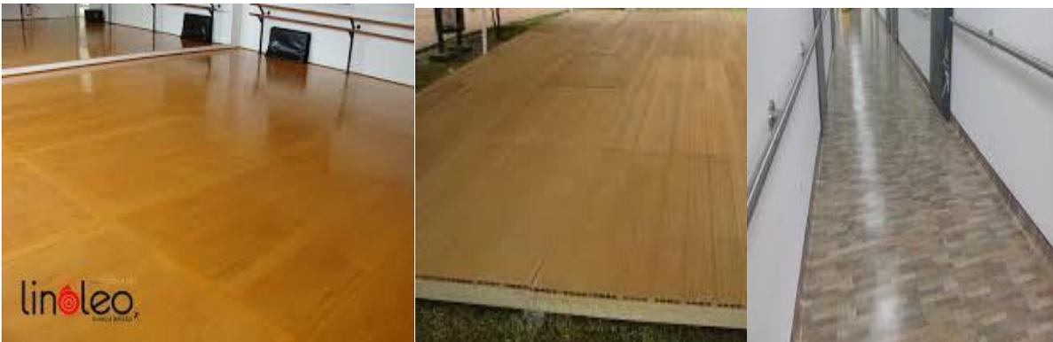
Fig. 68. Pisos plásticos de linóleo, losas plásticas y vinil.
