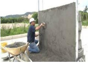
Fig.45. Repellos de muros
