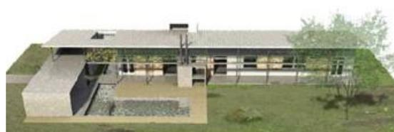
de radiación solar. La disposición busca en forma pasiva evitar ganancias de calor en verano y lograrlas en invierno. El aire de los ambientes interiores es renovado por flujos de vientos de direcciones predominantes (nordeste y sudeste). El proyecto propone la reutilización de aguas pluviales y la de aguas grises.
