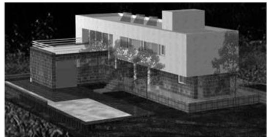
doble de ladrillo hueco cerámico con 7.5 cm de aislante EPS y losas de hormigón armado con 10 cm de aislante EPS. Aberturas de PVC con doble vidriado hermético y vidrios DVH 4+9+4 BE. Con el vidrio interior de baja emisividad, este disminuye las pérdidas de calor. Las puertas exteriores son de PVC con una parte traslucida con vidrio DVH 4+6+4.
