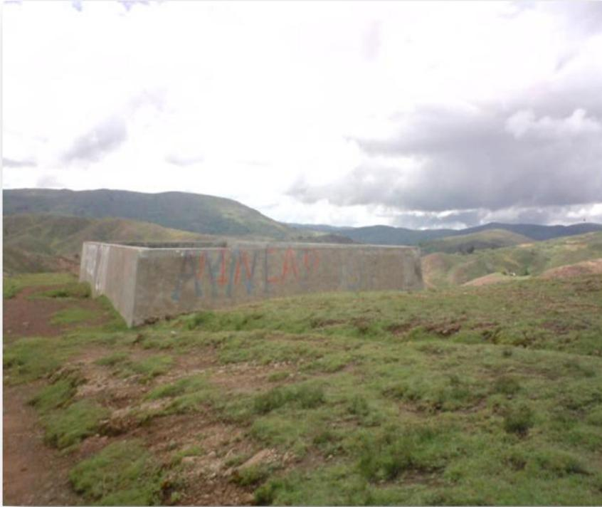
**Figure 9 Ccasapata, pozo de reserva agua potable.**
