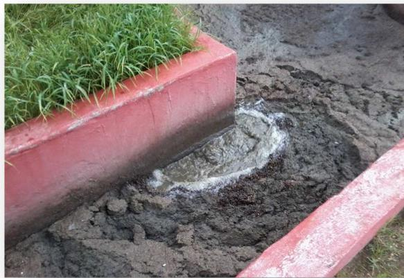
*Fig. 3.4. Escape de gas del biodigestor*
