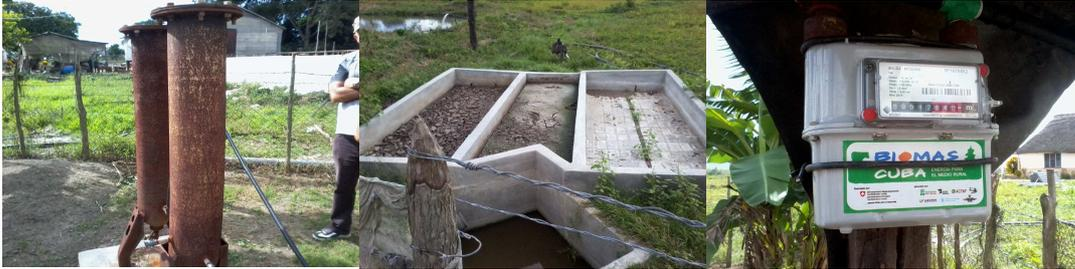
*Fig. 3.3. Elementos de la planta operada por Rogelio Rodríguez: a) Filtros para sulfuro de hidrógeno; b) lechos de secado; c) metro-contador de biogás*
