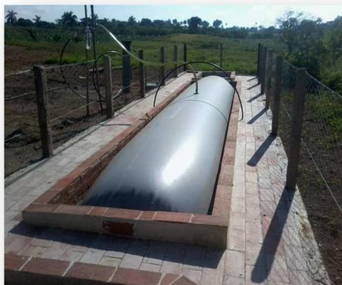
*Fig.3.1. Biodigestor desprotegido de las condiciones climáticas*
