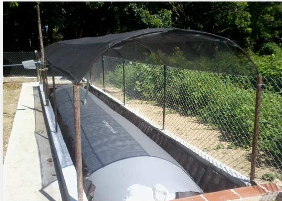
*Fig.3.2. Biodigestor protegido de las condiciones climáticas*
