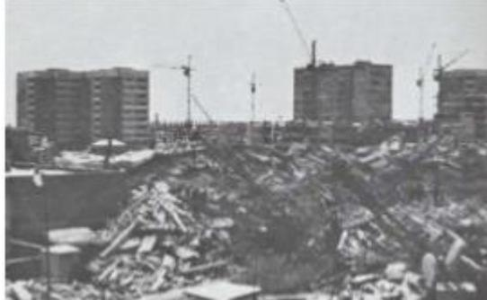
**Figura 1.1:** Colapso de edificios prefabricados por los efectos de un terremoto. 1988, Spitak (Armenia).(Pérez n.d.)
