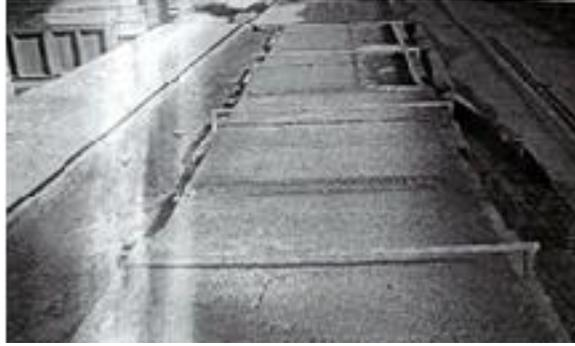
Fig.1.3 Hormigonado de las plaquetas
